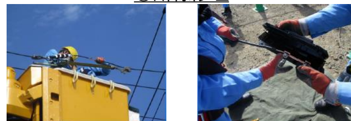
② 断線修理
