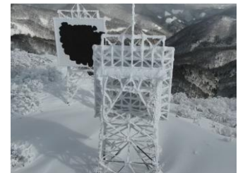
ドローンによる巡視
