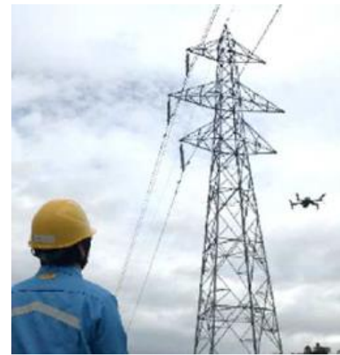
ドローンを活用し地上 から点検実施
