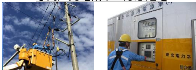
① 高圧発電機車の応急送電
