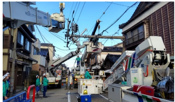
折損した電柱の改修
