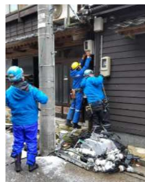
漏電火災防止のため送電前の漏電調査
