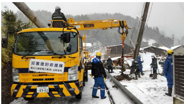
傾斜した電柱の改修
