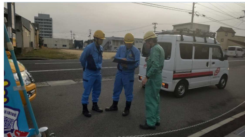
高圧発電機車の設置位置の確認
